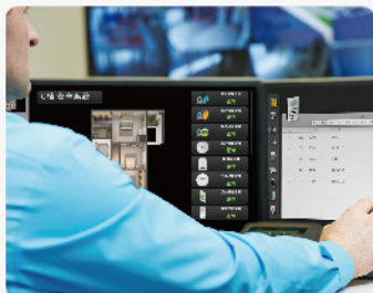
隨時監控各樓層設備狀態
